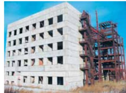
Рис. 2. Челябинский завод для термической переработки ТБО «Термоэкология», проектной производительностью 150 тыс. т отходов в год (по состоянию на 2006 г.): каркас котла; административный корпус
