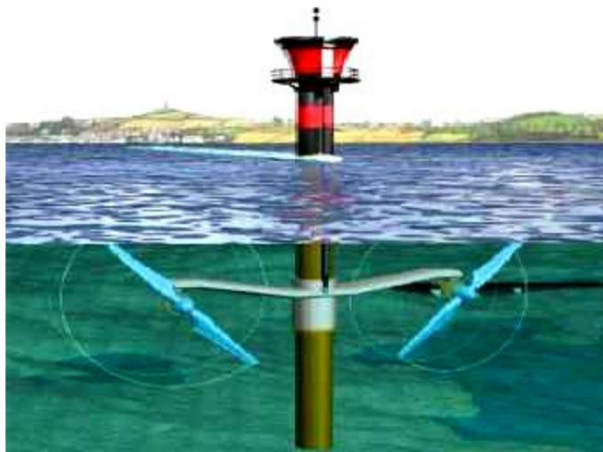
Рис. 7. 7. Электростанция SeaGen (Северная Ирландия), работающая на приливном течении
