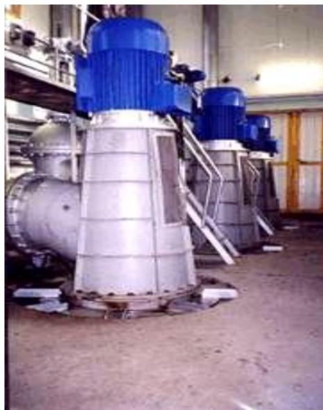
Рис. 3.12. Машинный зал микроГЭС
